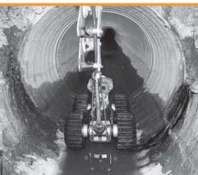
Телевизионная диагностика трубопровода наружной канализации с применением системы телеинспекции Rower
