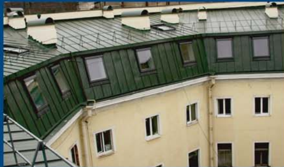
Строительство жилой мансарды на Невском проспекте, дом 3, 2009 г.
