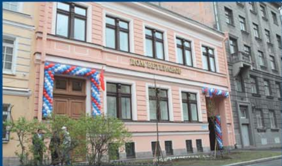
Реконструкция и реставрация нового здания Дома ветеранов, 2008 г.
