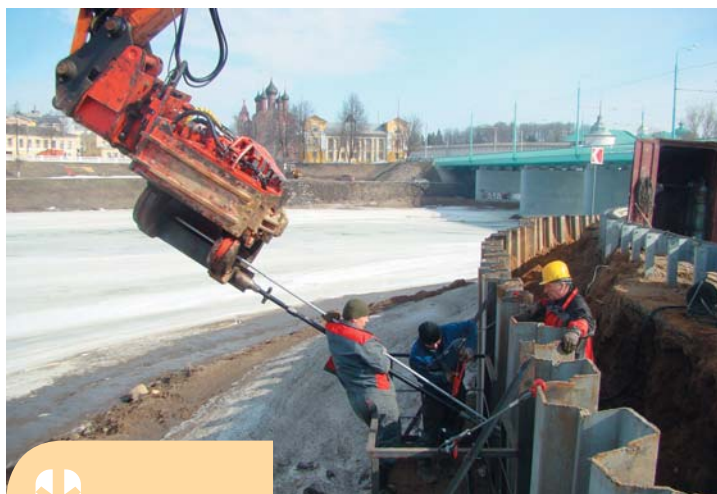
Применение анкеров Manta Ray в г. Ярославле. Укрепление шпунтового ограждения действующей дорожной развязки
