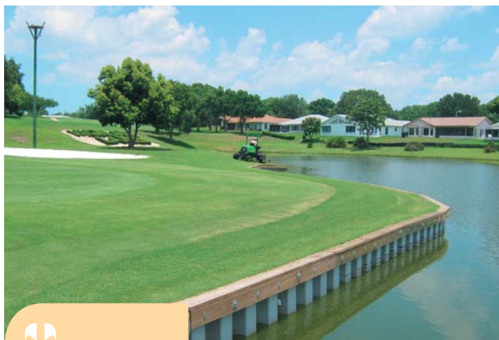
Применение шпунта ПВХ, США, штат Флорида
