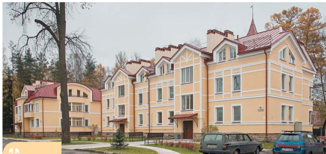
Строительная система VELOX позволяет экономить на времени и себестоимости строительства. Однако качество остается на высоте
