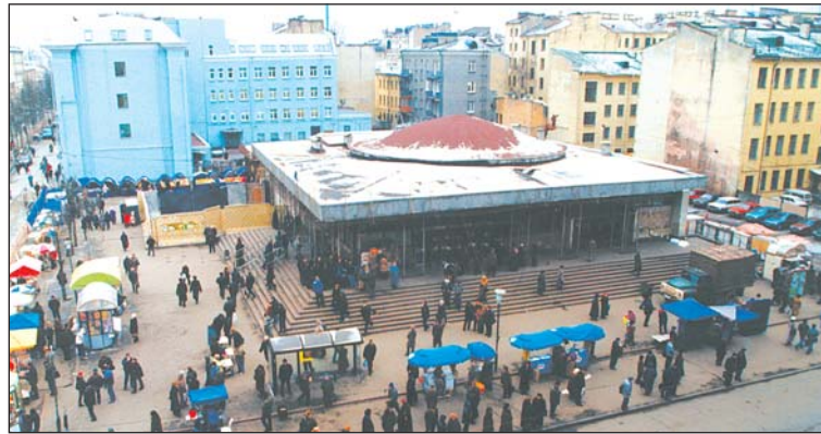
Строительство нового вестибюля не разрешит сложную ситуацию на станции «Василеостровская» в часы пик
