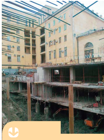
Работы по устройству подземного паркинга офисного здания по адресу: наб. реки Мойки, 74 (во дворе Комитета по строительству Санкт-Петербурга)
