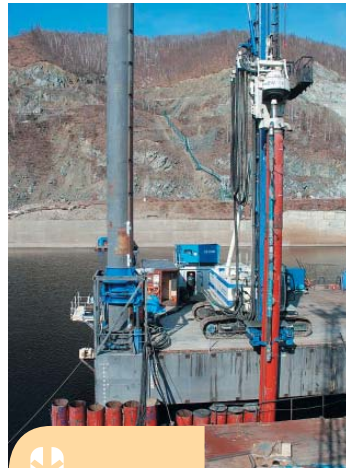
Работы на Зейской ГЭС. Устройство шпунтовой конструкции из металлических труб. Работы ведутся с морской буровой платформы
