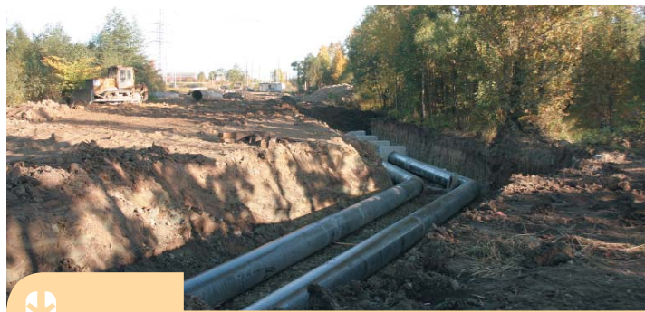
Реконструкция газопроводов в зоне строительства транспортных развязок на пересечении КАД с Пулковским шоссе
