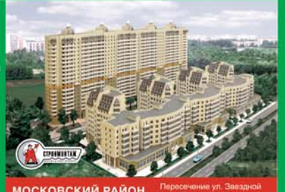
МОСКОВСКИЙ РАЙОН Пересечение ул. Звездной и ул. Пулковской
