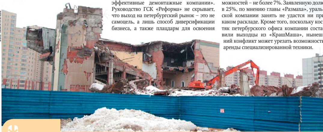
➔ Рынок демонтажа в Петербурге, по разным оценкам, составляет 1-2 млрд рублей
