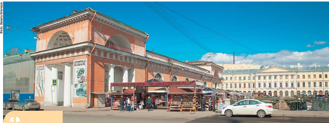
Работы по обследованию зданий в двух зонах общей площадью 126 га лягут в основу масштабной реконструкции исторического центра, которая может начаться в конце 2015 года
