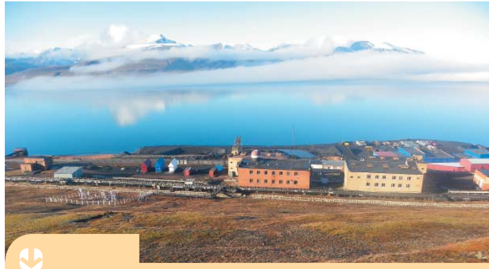
ООО «Управление строительных и проектных работ» осуществляло строительный контроль «Российского научного центра на архипелаге Шпицберген» в пос. Баренцбург
