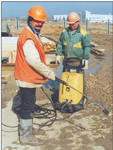
5. Устройство «Мойдодыр» должно уберечь город от неизбежной грязи стройплощадок
