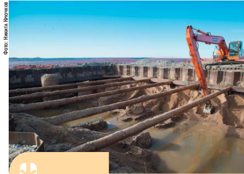
Разработка котлована под опору основного хода эстакады на участке Канонерский остров
