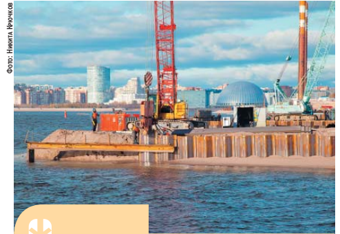
Погружение шпунта с временной технологической площадки
