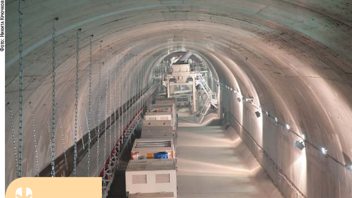
Стоимость проходческого щита вместе с его монтажом составляет 32 млн EUR
