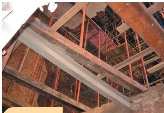
Замена деревянных балок перекрытий на металлические
