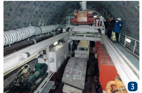
1 – щит «Виктория». Подготовка к кессонным работам; 2 – митинг по случаю окончания проходки; 3 – первый в России щит с бентонитовым пригрузом
