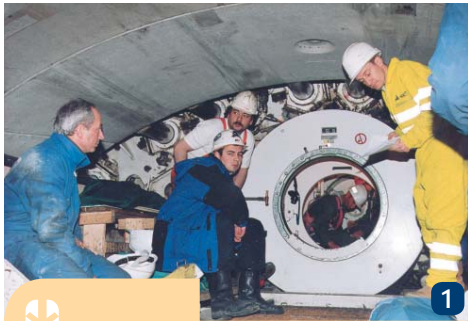
1 – щит «Виктория». Подготовка к кессонным работам; 2 – митинг по случаю окончания проходки; 3 – первый в России щит с бентонитовым пригрузом
