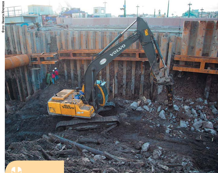
Подземное строительство при соблюдении новых технологий безопасно для прилегающих зданий
