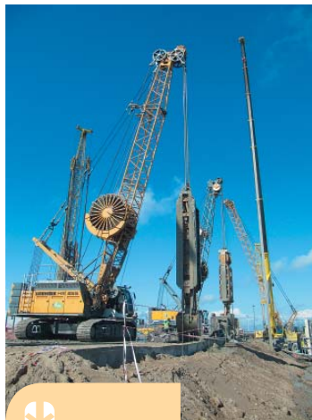
Устройство конструкции «Стена в грунте» сотрудниками компании ЗАО «Геострой»
