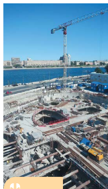
Площадка строительства Арбитражного суда г. Санкт-Петербурга и Ленинградской области по адресу: ул. Смольного, 6. Компания ЗАО «Геострой» использует в своей работе передовую технологию при возведении подземных этажей top down
