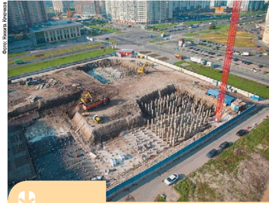
Строительство ЖК «Морская звезда» отстает от заданных сроков
