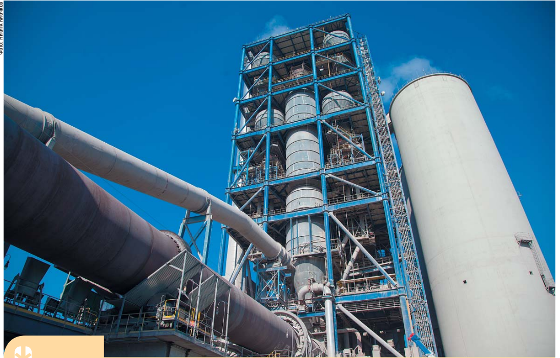
В теплообменнике с декарбонизатором происходит предварительный нагрев сырьевой муки и выделение из известняка углекислого газа
