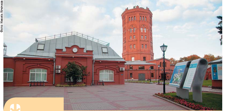
Блок двухступенчатой очистки и обработки воды на Главной водопроводной станции был введен в эксплуатацию еще в 1932 году
