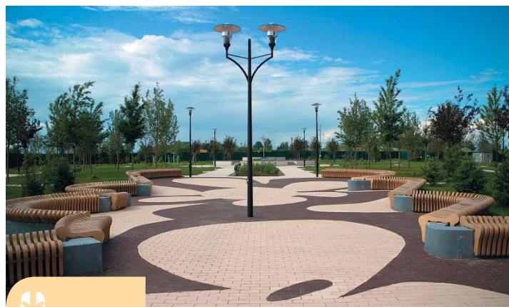
Клинкерное мощение долговечнее асфальтобетонного и цементно-песчаного покрытия, а значит, перспективно и при бюджетном финансировании
