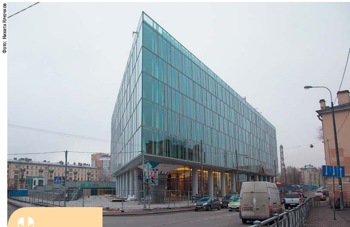
В настоящее время на территории района ведется строительство четырех бизнес-центров класса А и одного бизнес-центра класса В
