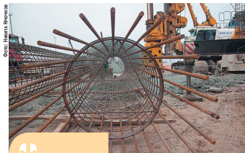
Армокаркас под сваи большого диаметра состоит минимум из 26 арматурных стержней
