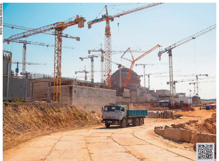
Ход строительства ЛАЭС-2
