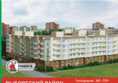
ВЫБОРГСКИЙ РАЙОН Генеральный подрядчик: ЗАО «ТОР-ИНВЕСТ»
