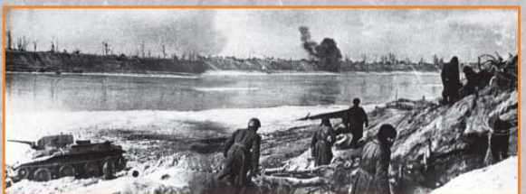
Строительство танковой переправы через реку Неву в ноябре 1941 года в районе Невской Дубровки
