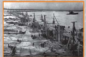
Процесс строительства моста через реку Неву. Общая панорама строительства
