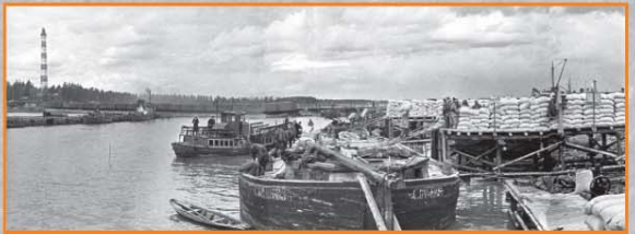
Сооружение пирсов на Ладожском озере
