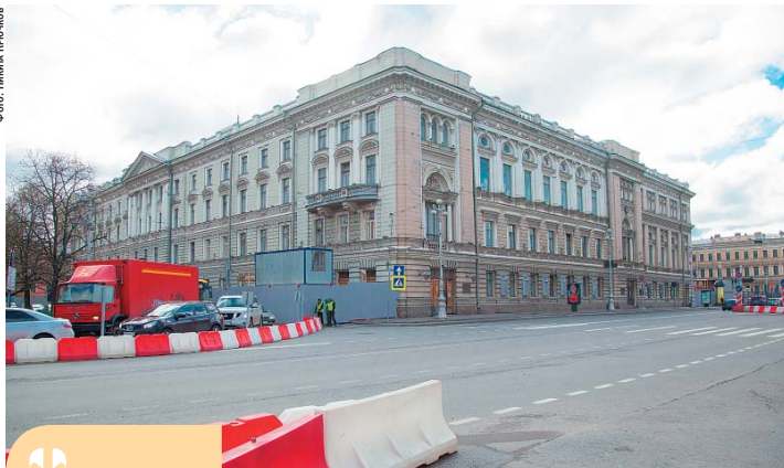
После окончания ремонтно-реставрационных работ здание на ул. Глинки, 2 оставят за Консерваторией
