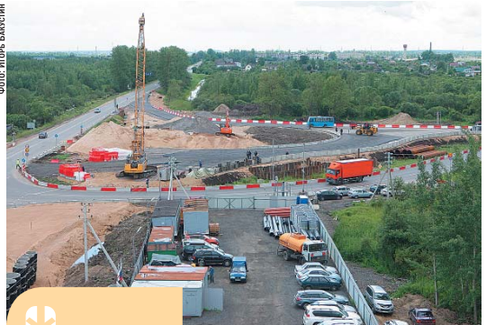
«Пилон» уже приступил к строительству разворотного кольца на Двинском шоссе
