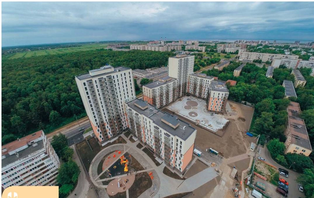
Завершение работ по благоустройству в I очереди строительства ЖК «Сандэй» (Сосновая Поляна 7-17)
