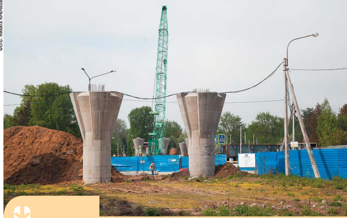
Развязка в створе Поклонной горы не строится, так как генподрядчик – «Мостоотряд № 19» – находится в стадии предбанкротного состояния
