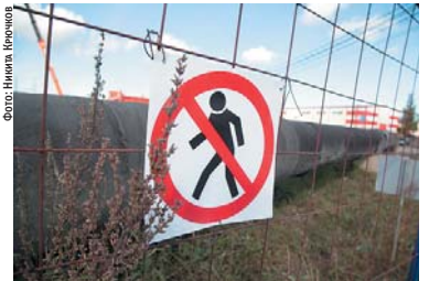
Реконструкция магистральной тепловой сети до котельной «Парнас»
