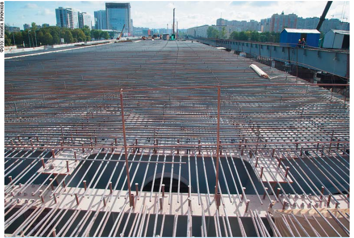
Работы на Пулковско-Дунайской развязке выполнены на треть
