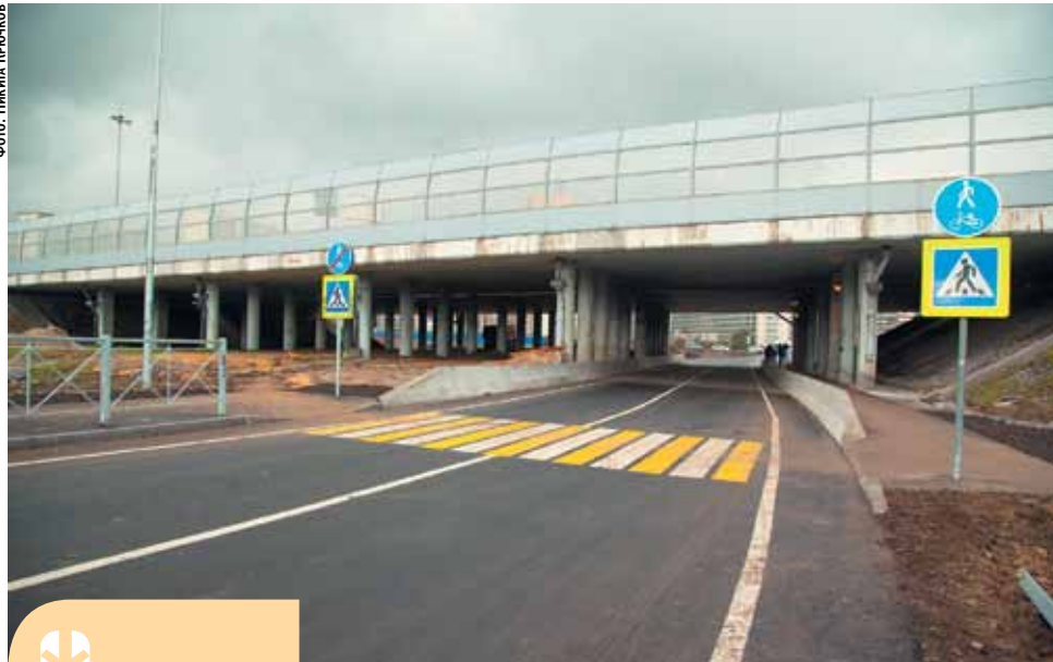
Проезд стал первым этапом строительства развязки с КАД в Мурино
