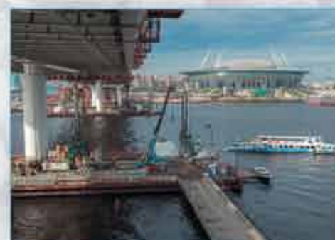
Строительство Западного скоростного диаметра. Центральный участок. Устройство защитных сооружений опор моста через Петровский фарватер
