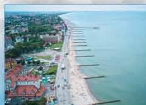
Современные берегозащитные гидротехнические сооружения. Строительство системы бун в г. Зеленоградске Калининградской обл.
