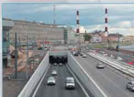
Реконструкция Синопской набережной от Херсонского проезда до Обводного канала. Строительство транспортного тоннеля
