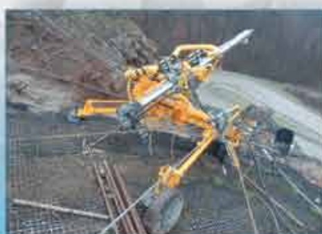
Комплекс работ по строительству и инженерной защите олимпийских объектов Сочи. Федеральная дорога А-149 «Адлер – Красная Поляна»
