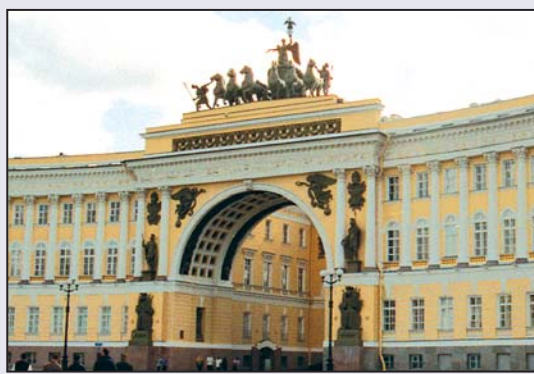
Здание Главного Штаба, в реставрации которого непосредственное участие принимало ООО «Фирма «Аргон»
