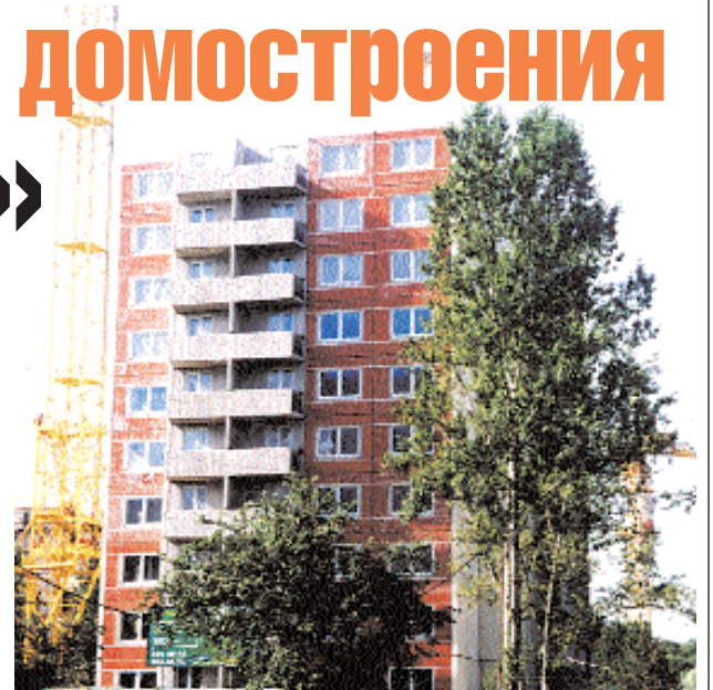
Нарядный керамический фасад крупнопанельного жилого дома 121 серии ЗАО «Гатчинский ДСК» на ул. Лени Голикова
