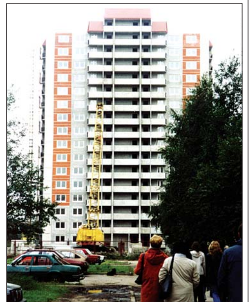
Сочетание панелей, облицованных плиткой, и панелей, предназначенных под окраску, в фасаде крупнопанельного жилого дома на ул. Чудновского
