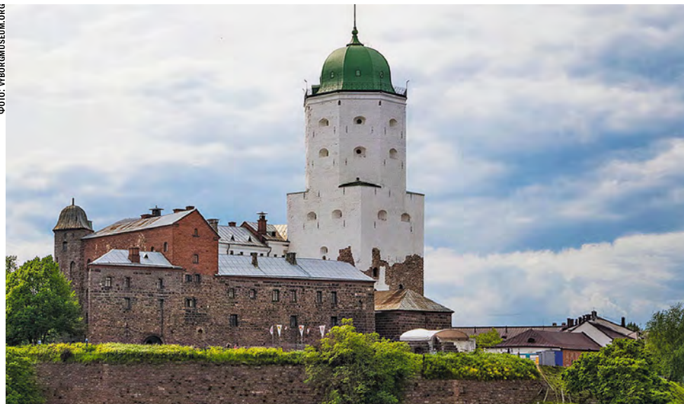
Скоро начнется комплексный ремонт объектов культурного наследия Выборга
