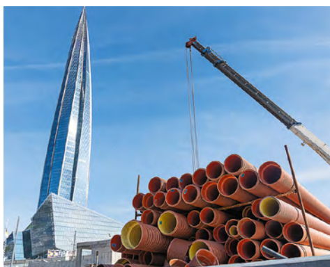
Канализационные трубы SUNSET при строительстве инженерной инфраструктуры возле «Лахта Центра»
